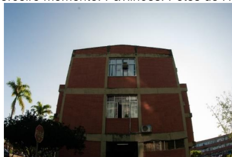
Figura 6 - Terceiro momento: Pavilhões. Fotos de Hévila Ferreira
