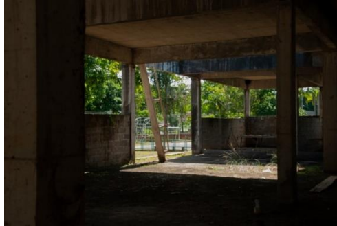
Figura 4 - Terceiro momento: Pavilhões. Fotos de Hévila Ferreira.
